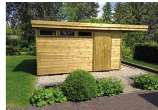
Comfort in geïmpregneerd hout
